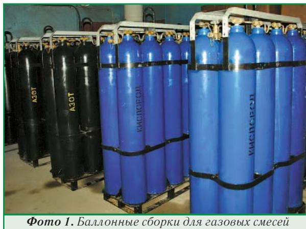
**Фото 1.** Баллонные сборки для газовых смесей
