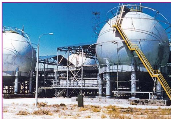
**Рис. 1.** Хранилище жидкого водорода объёмом 11000 м<sup>3</sup> на базе резервуаров РС-1400/1
