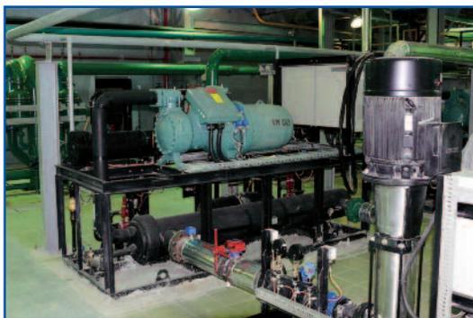
**Фото 8.** Холодильная машина системы предварительного охлаждения перерабатываемого воздуха
