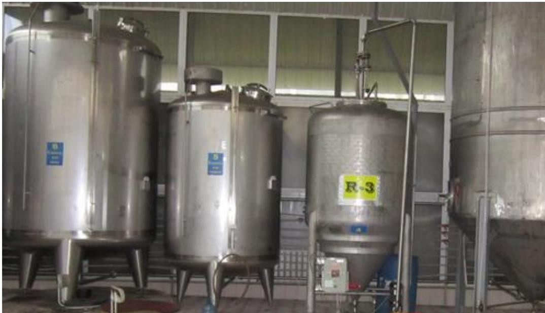
Рис. 3 Опытно-промышленный реактор R3 с местным щитом управления
