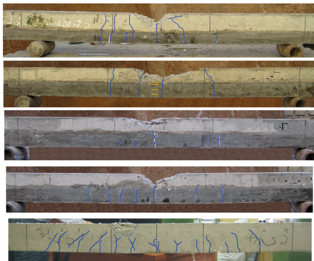
Рис. 6. Разрушенные двухслойные каутоно-бетонные балки и железобетонная балка
