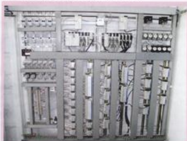
Рис. 1. Пример АСКУЗ двух поршневых компрессорных установок, реализованной на PLC фирмы «Modikon»
