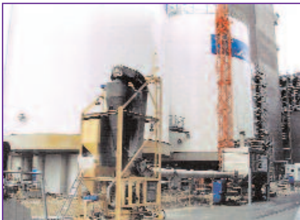
Фото 11. Вид работающего мобильного комплекса холдинга ЗАО «Группа компаний «Бентпром» на одном из объектов, сооружаемых «Linde AG»
