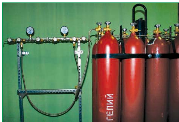
Фото 1. Подключение моноблока к разрядной рампе
