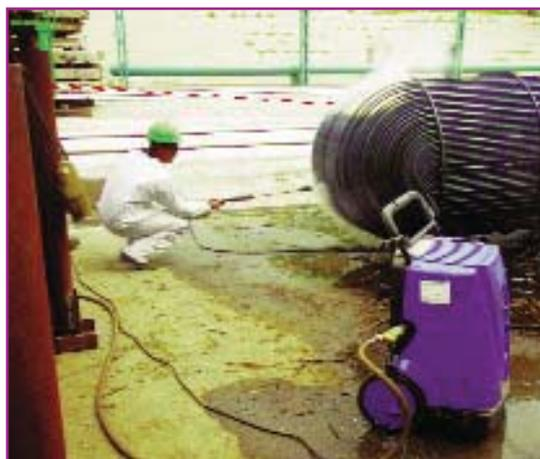
**Рис. 1.** Гидродинамическая очистка наружной поверхности трубок теплообменника от загрязнений
