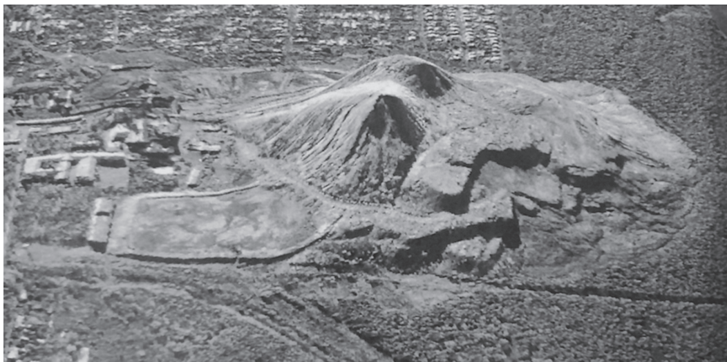
Рис. 1. Знімок породного відвалу шахти «Трудівська» № 5-біс
