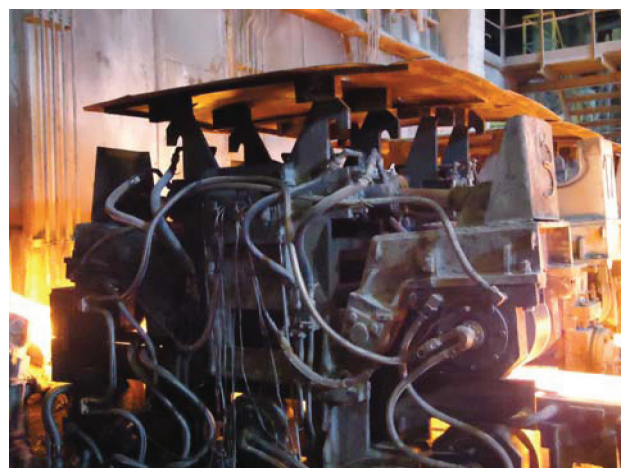
Рис. 1. Общий вид тянуще-правильного устройства шестиручьевого сортовой МНЛЗ Енакиевского металлургического завода
