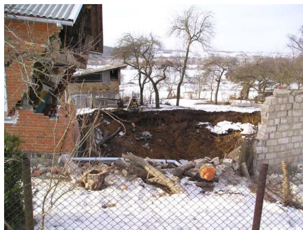
Рис. 1. Провал жилого дома в полость
