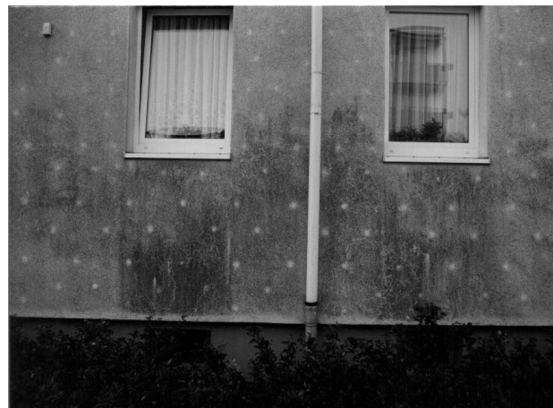
Рис. 1. Пример биогазряднения фасада здания (северная Германия)
