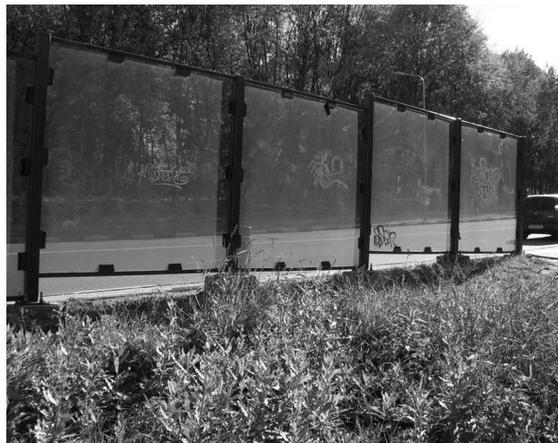
Рис.3. Элемент шумозащитного экрана в г. Харькове с видимыми недостатками – щелями
