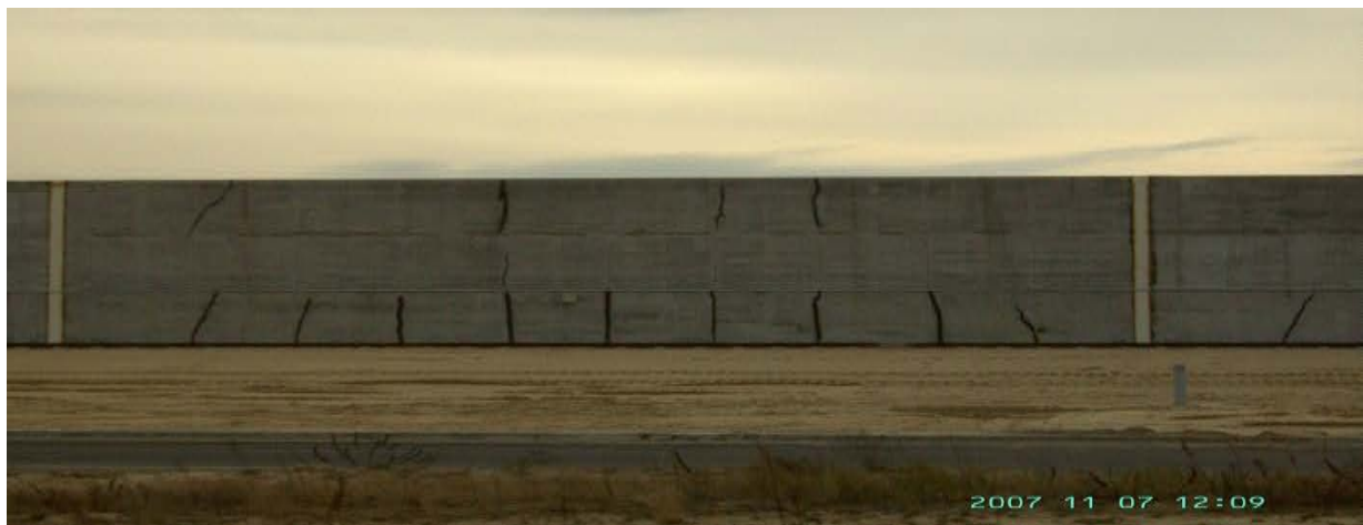
Рис.10. Воздействие геодинамических зон на целостность стен хранилища радиоактивных отходов РАО (по данным академика НАНУ В.М. Шестопалова).
