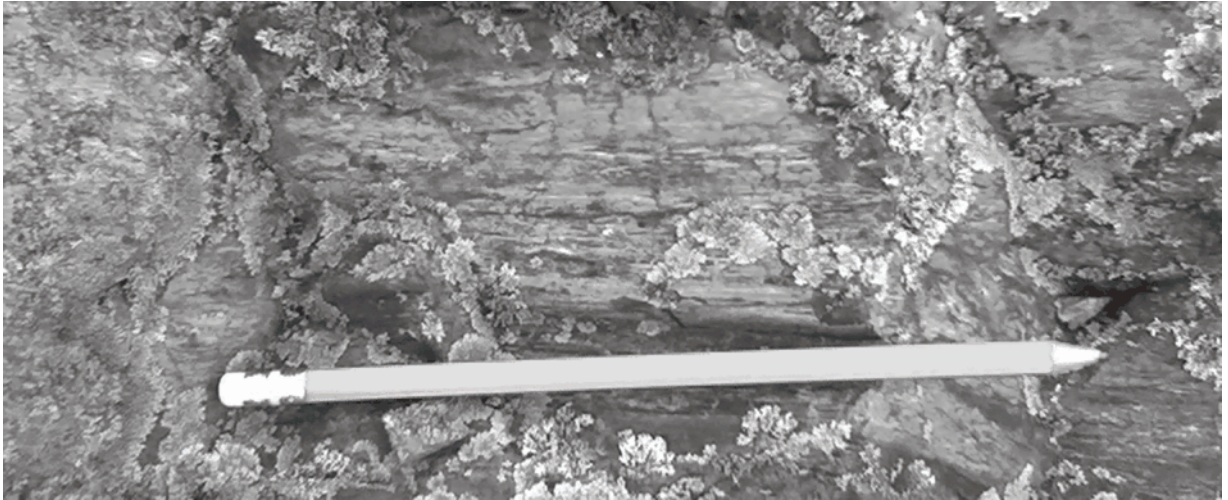
Рис. 3. Пример зеркала скольжения с горизонтальными штрихами (правый сдвиг). Левый берег р. Ингул в с. Завадовка.
