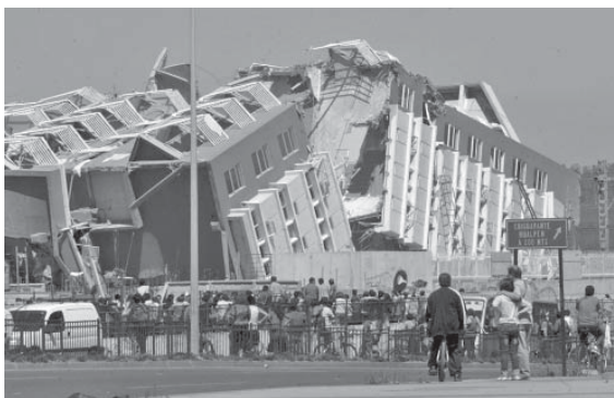
Рис. 1. Разрушенное сейсмостойкое здание в г. Консепсьон.
