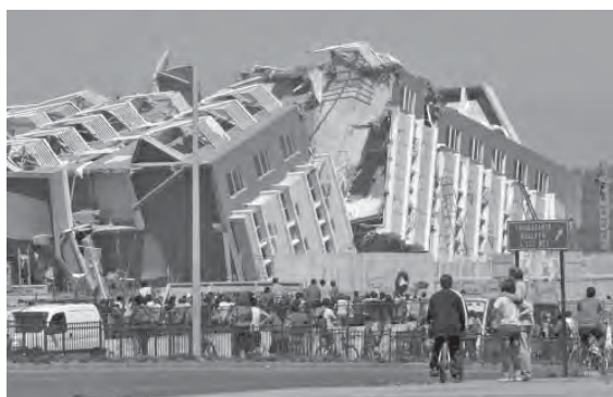
Рис. 1. Разрушенное сейсмостойкое здание в г. Консепсьон.
