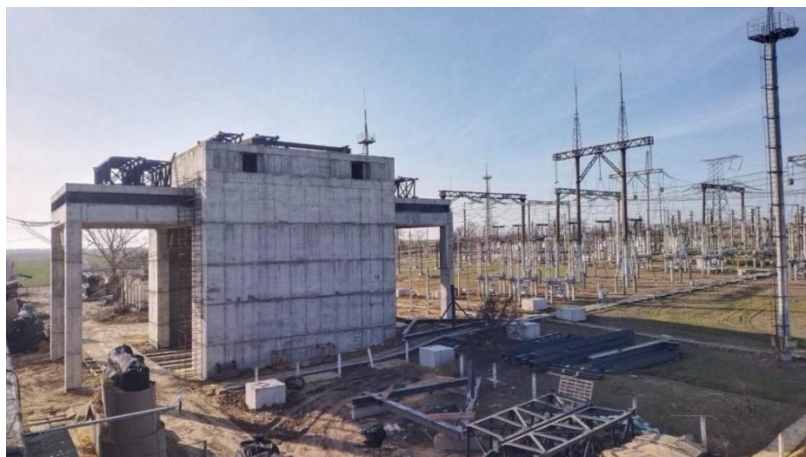
Рис. 2. СІЗ 2 рівня, в процесі завершення будівництва (до прикладу 2)
