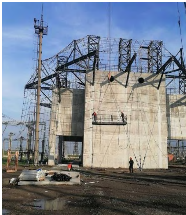
Рис. 1. СІЗ 2 рівня, в процесі завершення будівництва (до прикладу 1)
