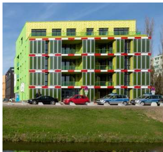
Перший експериментальний будинок BIQ house, що генерує енергію за допомогою розташованих на його фасаді панелей з мікроводоростями (м.Гамбург, Німеччина)
