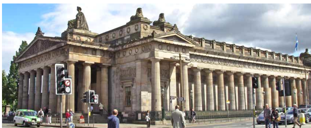
Рис. 5. Здание Национальной галереи Шотландии. Арх. В. Плейфер, 1853 г.
