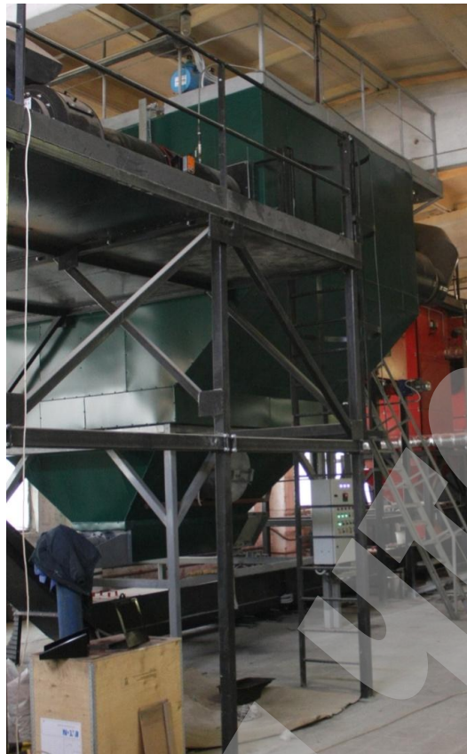
Рис. 1. Інсинераторна установка для спалювання, радіоактивно-забрудненої деревини з видалення забруднених продуктів згоряння з димових газів
