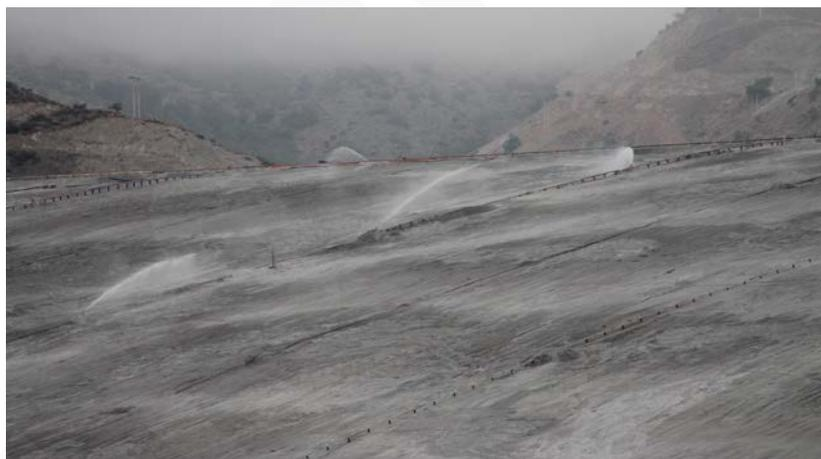
**Рис. 3.** Технология увлажнения пылящих поверхностей хвостохранилища Мауро на медно-молибденовом руднике Лос-Пеламбрес в Чили (фото) [19]
