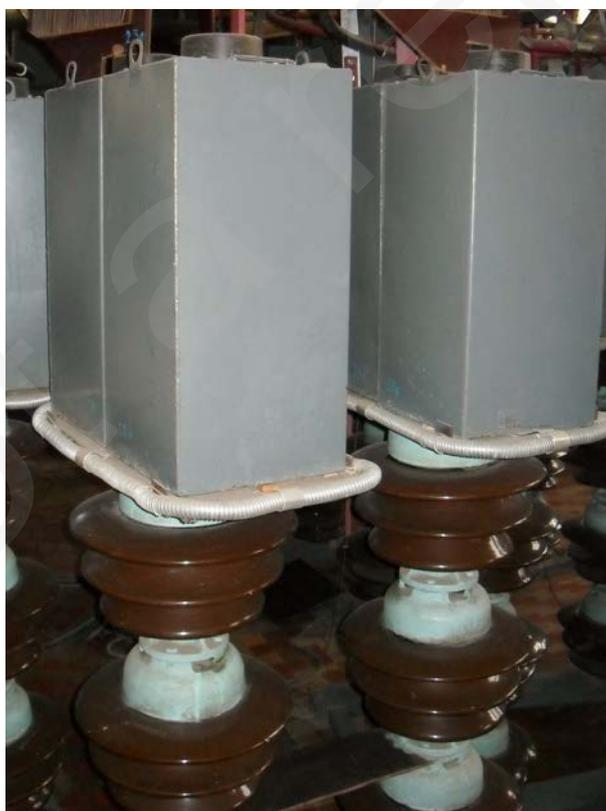
**Рис. 4.** Монтаж конденсаторов ИК-50-3 на опорные изоляторы для обеспечения необходимой изоляции от земли в генераторе импульсных напряжений
