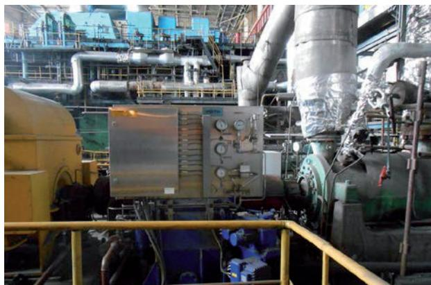
**Рис. 2.** Гидромuftа VOITH 682 SVNL 336 в приводе питательного насоса ПЭ 720-185 на Кураховской ТЭС
